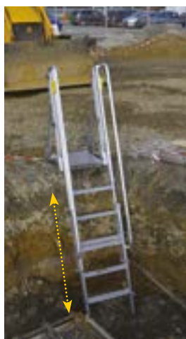
Piètements télescopiques réglables sur 4 hauteurs.
