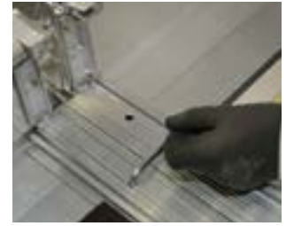
Fixation des 2 planchers par crochets imperdables.
