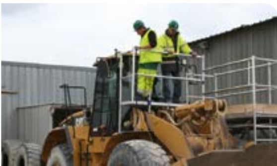
Echafaudages pour intervention sur engins de carrière
